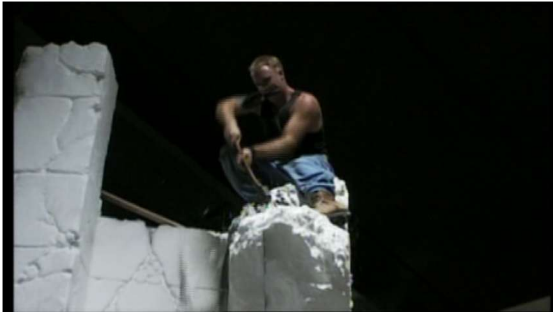
Fig 13. Construction de décor du film Le Seigneur des Anneaux : La Communauté de l'Anneau de Peter Jackson (décor en plâtre et polystyrène).
